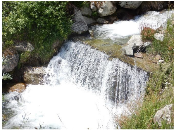
Sperre mit Absturz, Blick entgegen der Fliessrichtung. DSCN5660.jpg
